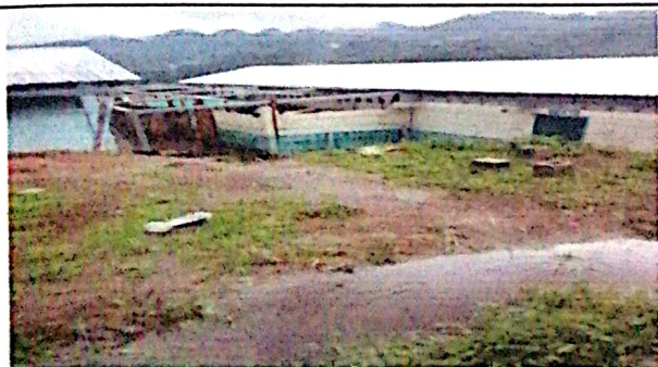
Foto 5: vista panoramica de las aulas del trabajos realizadas del remozamiento
