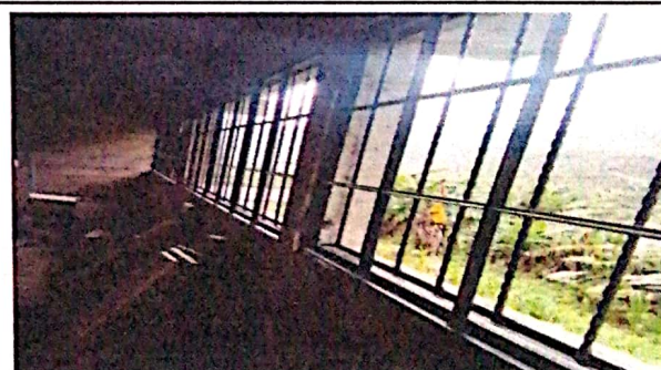
Foto 4: Instalacion de ventanas de metal de las aulas del centro estudiantil
